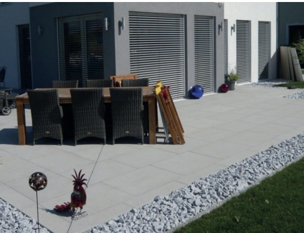
Terrassen- und Balkonbelag Betonplatte
